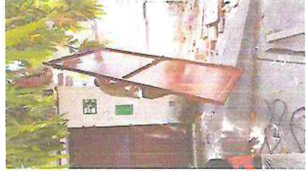
Foto 8: Mantenimiento a puertas de sanitarios
