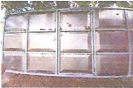
Foto 1: Instalación de potón de metal 5.10m de largo 2.30 de alto
