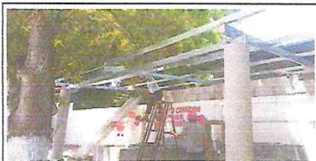
Foto 6: Instalación de lámina, por lámina troquelada alizinc calibre 26 en el área de la pila.
