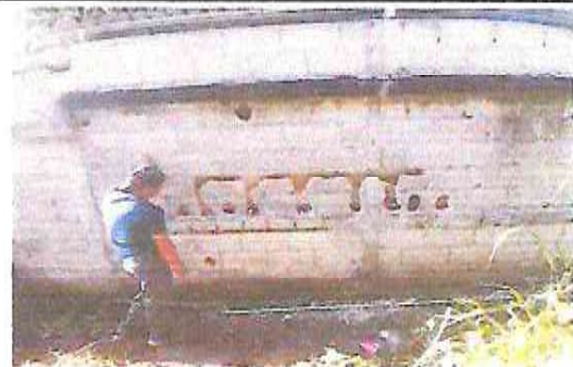
Foto 4: Instalación de tuberías a los sanitarios.
