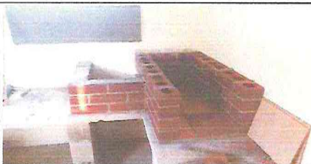
Foto 5: Instalación de estufa rural (Completa) incluye chimenea y plancha de metal.
