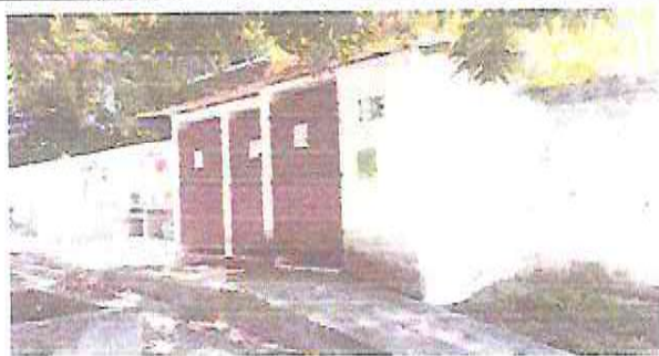
Foto 12: Cambio de tubería a los sanitarios y mantenimiento de puertas
