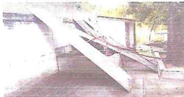
Foto 6: Sustrución de lámina, por lámina troquelada aluzinc calibre 26 en el area de la pila.
