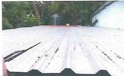
Foto 2: Sustitución de lamina por lamina troquelada aluzinc cal. 26
