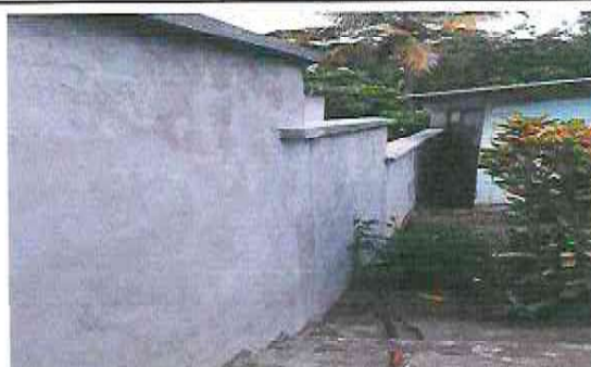
Foto 6: Mejoramiento de muro perimetral (sustitución de malla por block)
