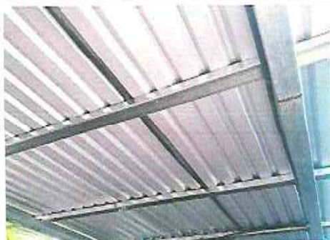
Foto1: Sustitución de estructura de madera por estructura metálica
