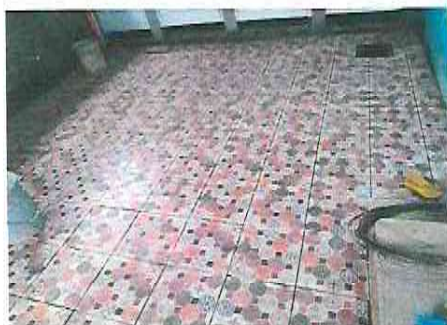
Foto 3: Sustitución de piso de torta de concreto por piso cerámico
