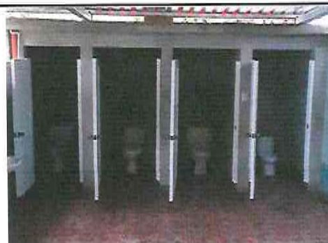
Foto 4: Sustitucion de servicios sanitarios con sus accesorios
