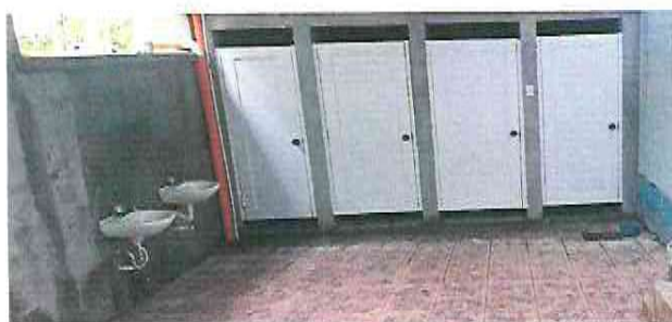
Foto 5: Sustitucion de puertas de metal por PVC
