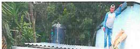
Foto 7: Sustitución de red de agua potable
