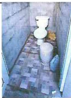
Foto 3: Sustitución de piso de torta de concreto por piso cerámico
