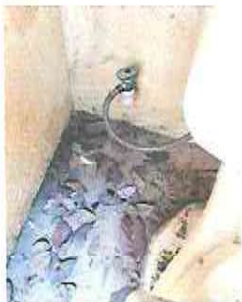
Foto 7: Sustrucción de red de agua potable
