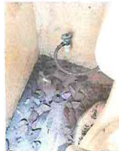
Foto 8: Sustrucción de red de drenajes
