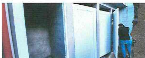
Foto 5: Sustitución de puertas de metal por PVC
