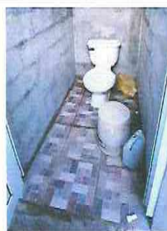
Foto 4: Sustitución de servicios sanitarios con sus accesorios
