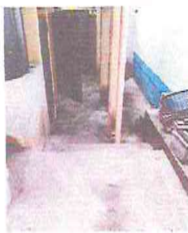
SUSTITUCIÓN DE PISO TORTA DE CONCRETO POR PISO CERAMICO
