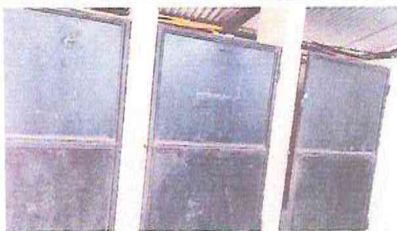
SUSTITUCIÓN DE PUERTAS DE METAL POR PVC
