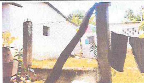
MEJORAMIENTO DE MURO PERIMETRAL (SUSTITUCIÓN DE MALLA POR BLOCK)
