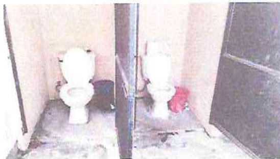
SUSTITUCIÓN DE SERVICIOS SANITARIOS CON SUS ACCESORIOS
