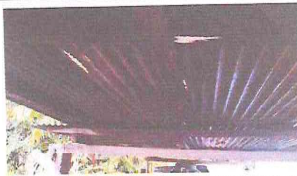
SUSTITUCIÓN DE LAMINA POR LAMINA TROQUELADA ALUZINC CAL. 26
