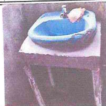
SUSTITUCIÓN DE RED DE DRENAJES
