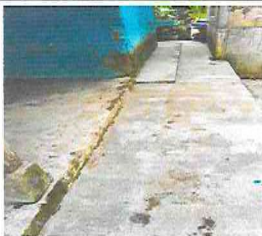
Foto 3: Reparacion de banqueta de concreto
