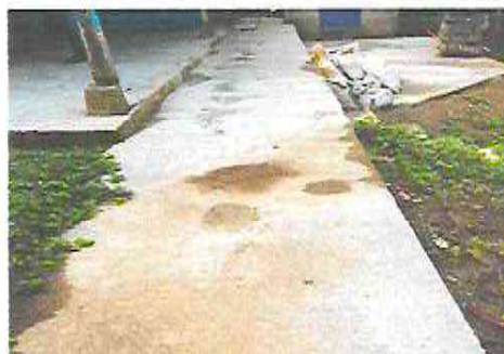
Foto 2: Reparacion de banquetas de concreto
