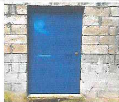
Foto 5: Sustitucion de puerta en cocina
