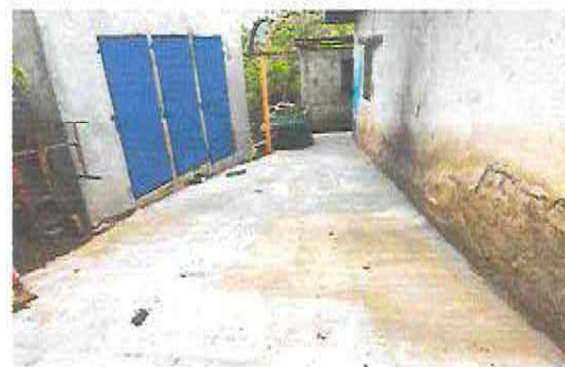
Foto 4: Sustitución de piso de torta de concreto
