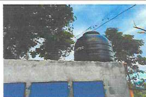
Foto 4: Suministro e Instalacion de deposito de agua
