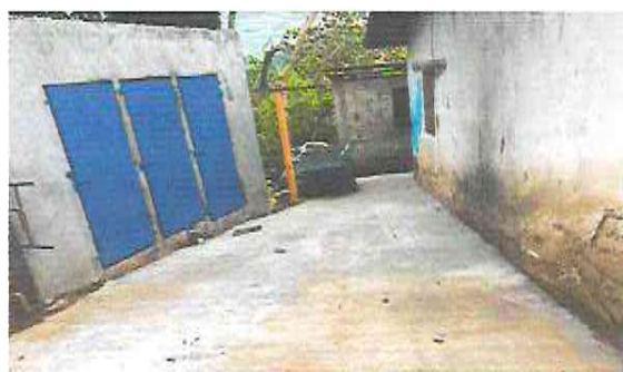
Foto 3: sustitución de puerta en servicios sanitarios
