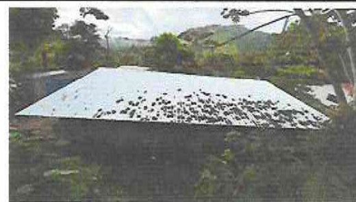
Foto 6: Sustitución de lamina, por lamina troquelada aluzinc calibre 26
