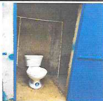
Foto 5: Sustitución de inodoros
