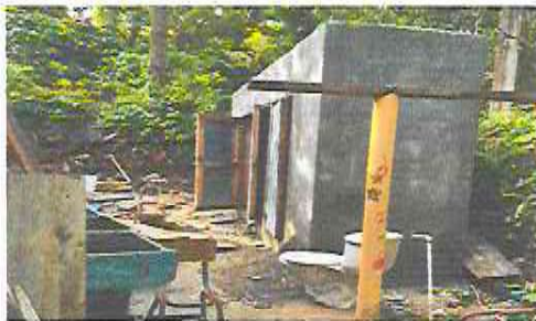
Foto 1: Sustrución de lamina, por lamina troquelada aluzinc calibre 50
