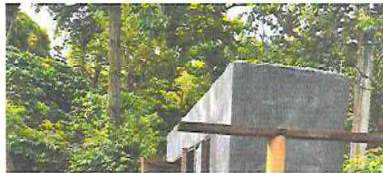
Foto 4: Suministro e Instalacion de deposito de agua
