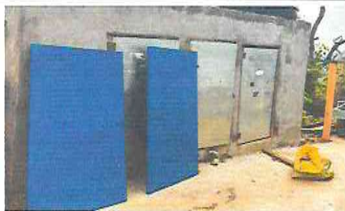
Foto 3: sustrución de puerta en servicios sanitarios
