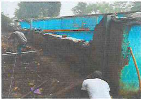
Foto 1: Sustitucion de estructura de soporte de madera por metal
