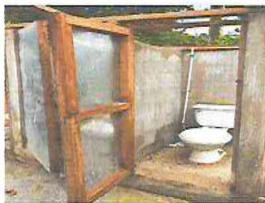
Foto 5: Sustrución de inodoros
