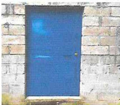
Foto 5: Sustitucion de puerta en cocina
