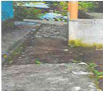
Foto 3: Reparacion de banqueta de concreto
