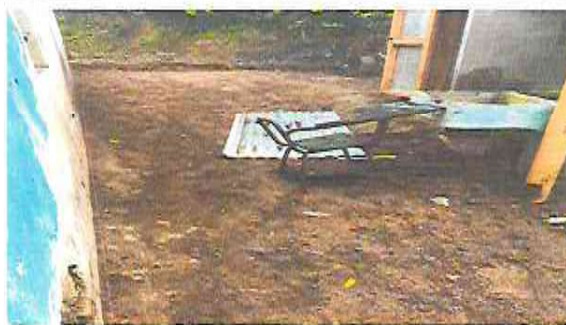
Foto 4: Sustrución de piso de torta de concreto
