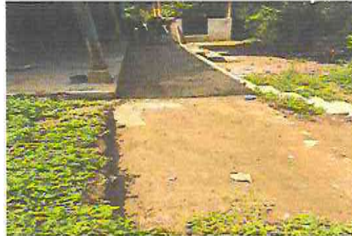
Foto 2: Reparacion de banquetas de concreto
