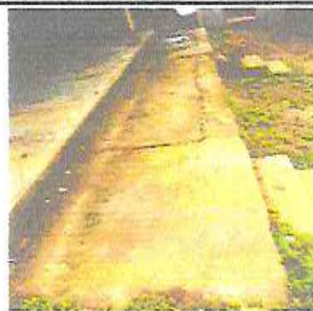
Foto 2: Reparación de banquetas de concreto
