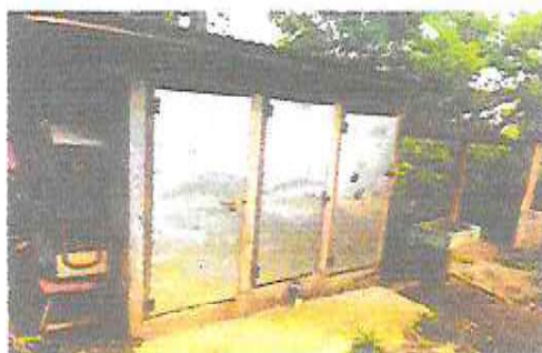
Foto 3: sustitución de puerta en servicios sanitarios
