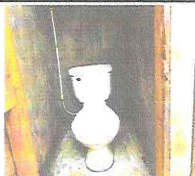
Foto 5: Sustitución de inodoros
