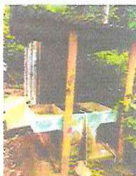
Foto 4: Suministro e instalación de depósito de agua
