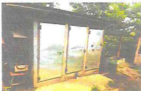
Foto 1: Sustitución de lámina, por lámina troquelada aluzinc calibre 50
