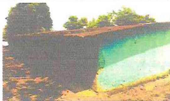
Foto 6: Sustitución de lámina, por lámina troquelada aluzinc calibre 26
