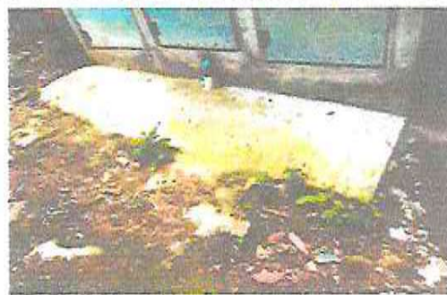
Foto 4: Sustitución de piso de torta de concreto
