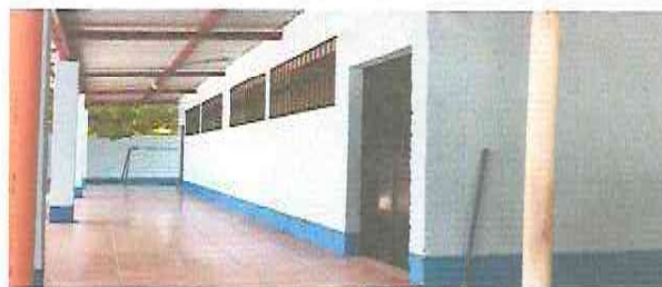
Foto 6: Puertas de metal
