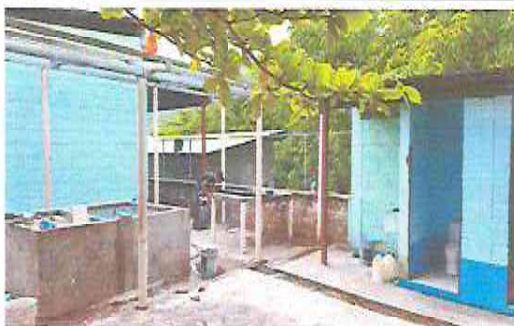
Foto 1 : Área de baños y lavamanos
