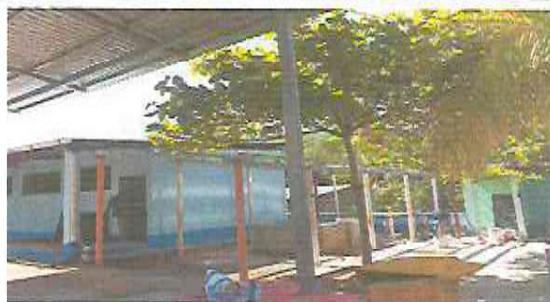
Foto 4: Sustitución de lámina por lámina troquelada y estructura metálica
