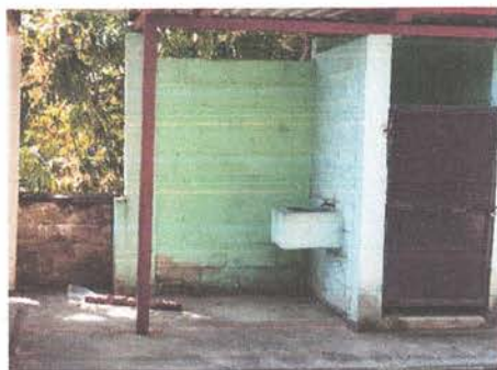
Sustitución de Lavamanos
