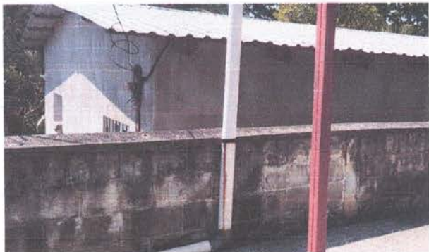
Sustitución de muro perimetral de block
