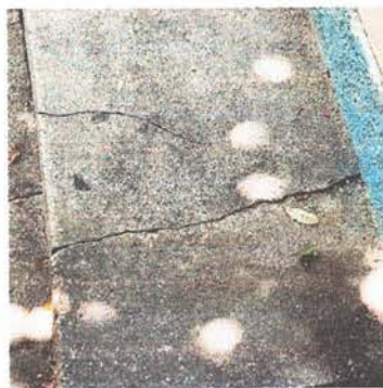
Sustitución de piso de torta de concreto
