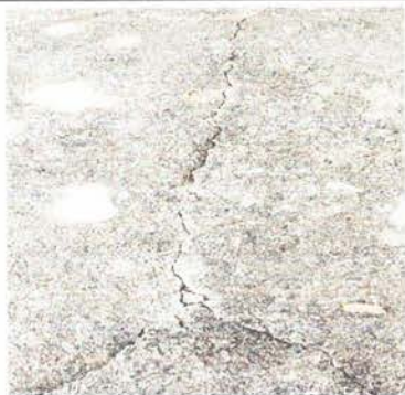
Sustitución de piso de torta de concreto
