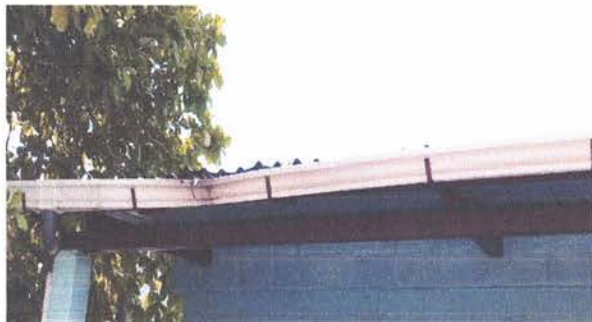
Sustitución de canales de bajada de agua pluvial con tubo de 3"
