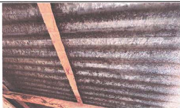
Sustitución de estructura de soporte de madera por metal (costanera)
