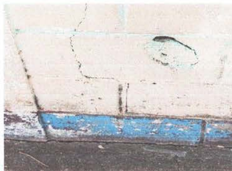
Sustitución de muro perimetral de block
