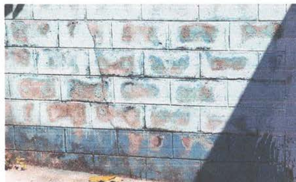
Pintura en muros interiores y exteriores
