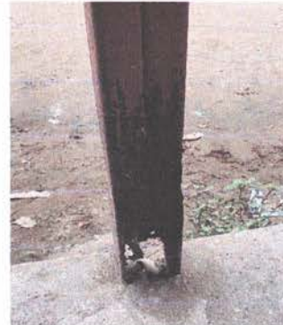
Sustitución de base de metal (muros) de galera adjunto a las aulas
