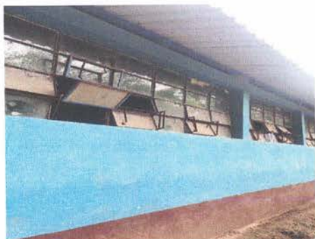
Sustitución de ventanas de metal y vidrio por ventanas corredizas de pvc
