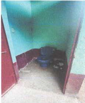
Sustitución de sanitarios con sus accesorios
