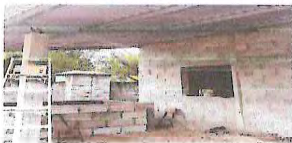
CONSTRUCCIÓN DE COCINA.
