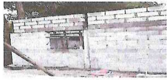
CONSTRUCCIÓN DE COCINA.
