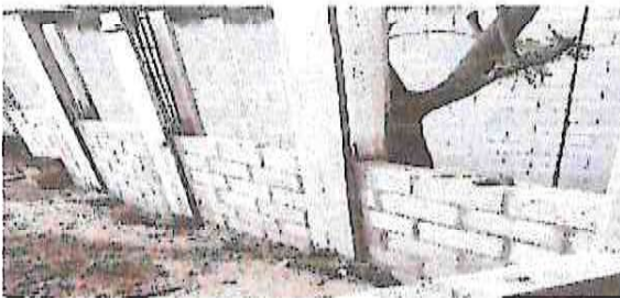
CONSTRUCCIÓN DE COCINA.
