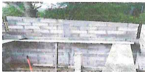
ESTANTERIA DE CONCRETO.
