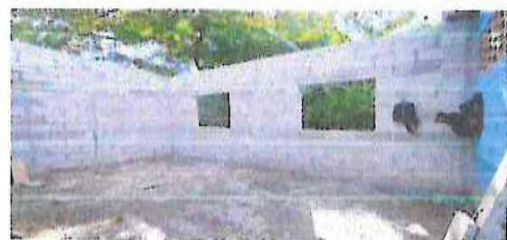
ESTANTERIA DE CONCRETO.
