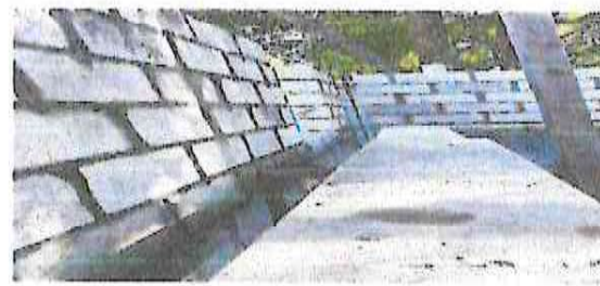
ESTANTERIA DE CONCRETO.
