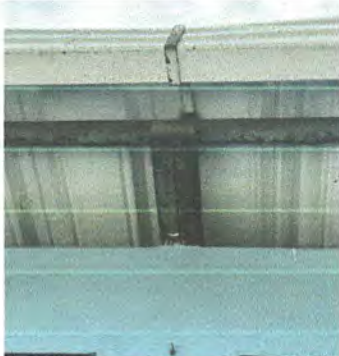
Foto 3: Sustrucción de estructura de soporte de metal (Costanera) por estructura de similar consistencia
