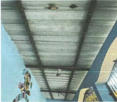
Foto 1: Sustrucción de estructura de soporte de metal (Costanera) por estructura de similar consistencia
