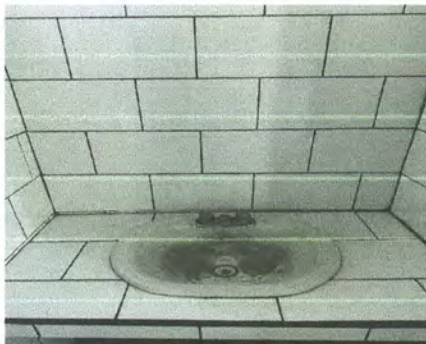
Foto 7: Sustitución de lavamanos
