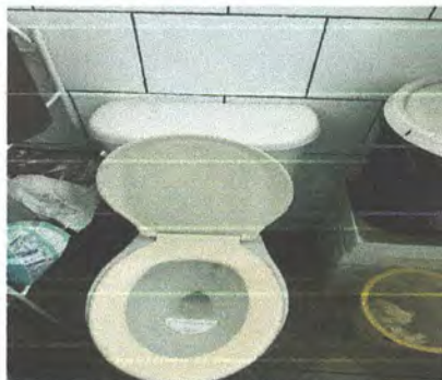
Foto 9: Sustitución de sanitarios con sus accesorios
