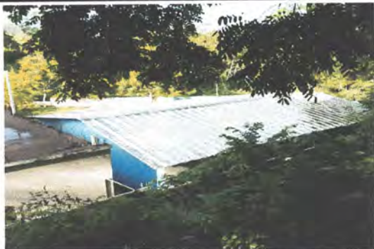
Foto 13: Sustrución de lámina por lámina troquelada aluzinc calibre 26
