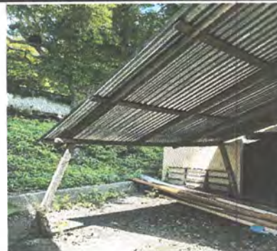
Foto 14: Sustrución de estructura de soporte de madera por metal (costanera)
