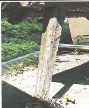
Foto 15: Sustrución de estructura de soporte de madera por metal (costanera)
