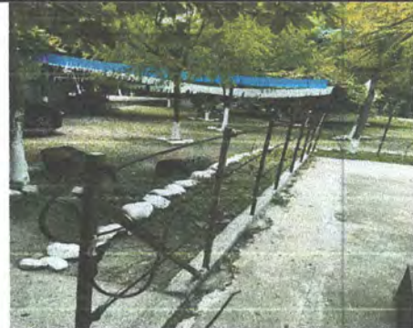
Foto 4: Sustrucción de estructura de metal de circulación oxidada por barandales de metal galvanizado más pintura
