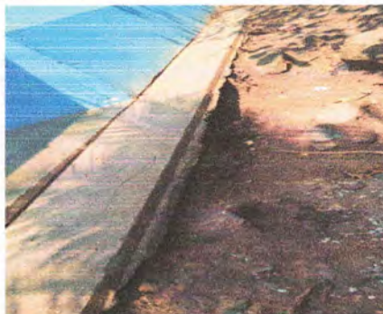
Foto 8: caminamiento de torta de concreto (banquetas)
