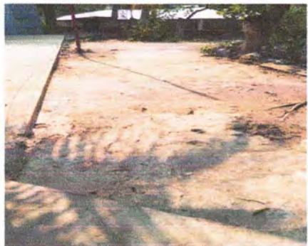
Foto 7: Sustitución de torta de concreto de cemento.
