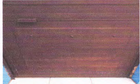
Foto 14: Reparación de estructura metálica de 2x1 incluye(lijado, sepillado, y pintura)
