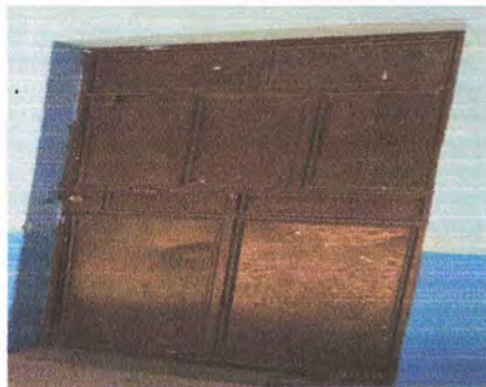
Foto 16: sustitución e instalación de purtas de la cocina.
