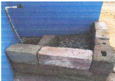
Foto 18: sustitución de pila de concreto por pila prefabricada.
