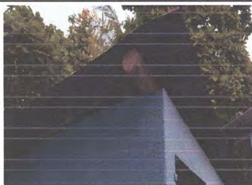
Foto 2: Sustitución de lámina por lámina troquelada alucín calibre 26.
