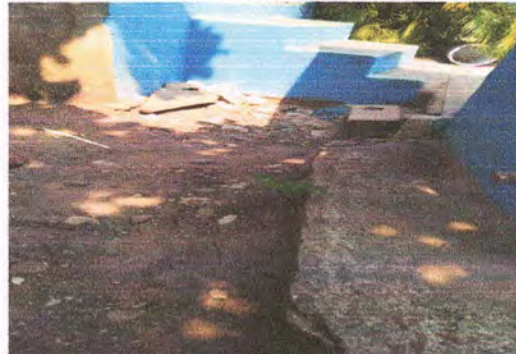
Foto 10: caminamiento de torta de concreto (banquetas)
