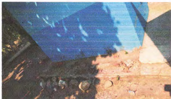
Foto 11: caminamiento de torta de concreto (banquetas)
