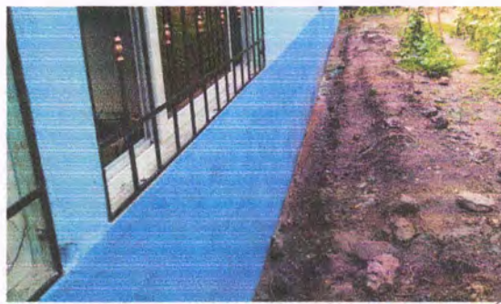
Foto 12: caminamiento de torta de concreto (banquetas)
