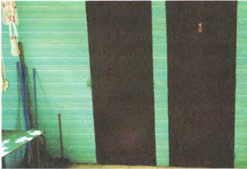
Foto 13: Reparación de estructura metálica de 2x1 incluye(lijado, sepillado, y pintura)
