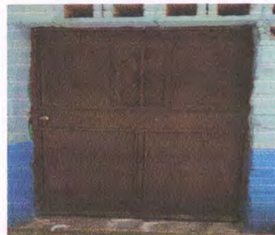
Foto 17: sustitucion e instalación de puertas de metal de la bodega.
