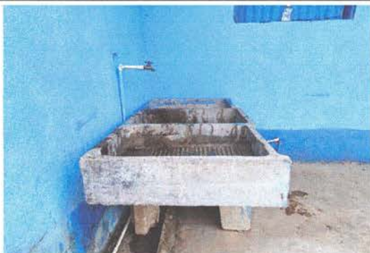
Sustitución de pila de concreto por pila plástica de dos lavaderos
