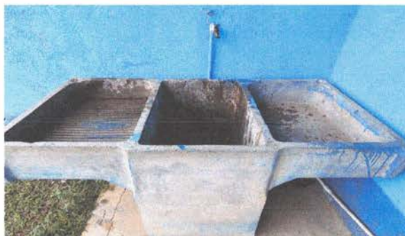
Sustitución de pila de concreto por pila plástica de dos lavaderos
