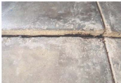
Sustitución de piso de torta de concreto dañada por piso ceramico en el area de las aulas
