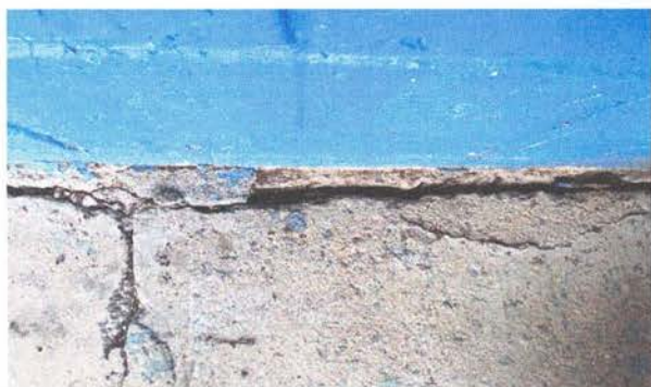
Sustitución de piso de torta de concreto dañada por piso cerámico en el área de las aulas
