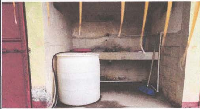
SUSTITUCION DE PILA DE UN LAVADERO
