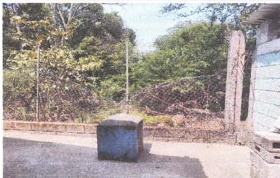
SUSTITUCIÓN DE MALLA PERIMETRAL
