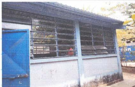
PINTURA DE INTERIOR Y EXTERIOR
