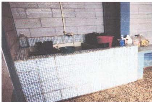
Mantenimiento a pila
