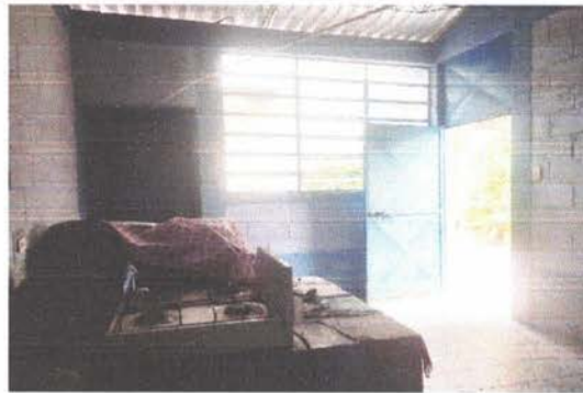
Sustitución e instalación de estufa completa (incluye polletón, plancha de metal y chimenea)
