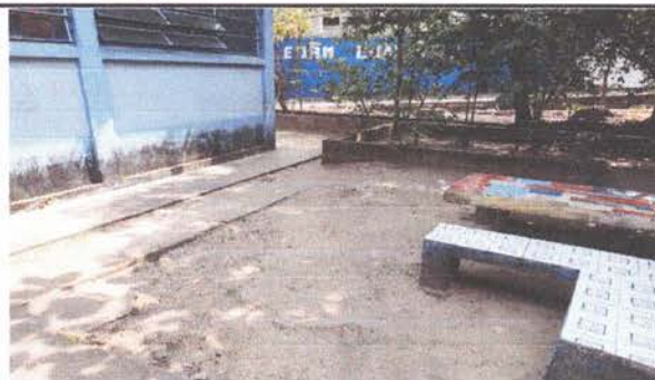
REPARACIÓN DE PISO DE CONCRETO
