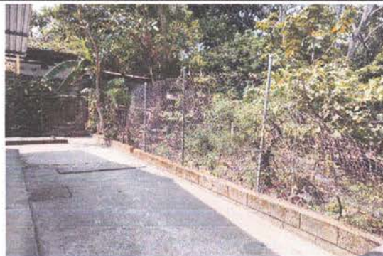
SUSTITUCIÓN DE MALLA PERIMETRAL
