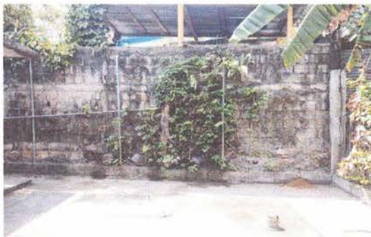
REPARACIÓN DE MURO PERIMETRAL
