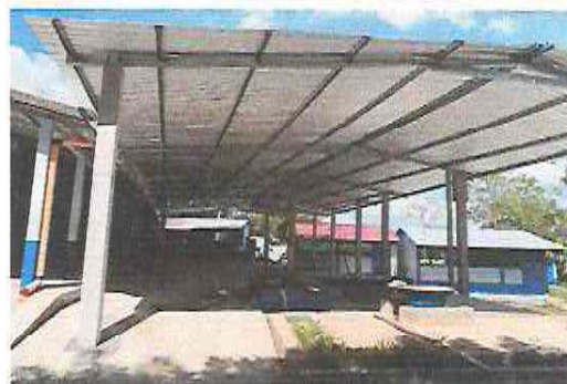
Foto 4: Suministro de lámina troquelada calibre 26 en modulo de patio
