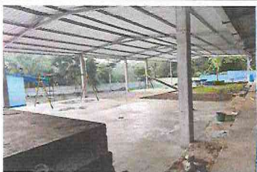
Foto 5: Suministro de lámina troquelada calibre 26 en modulo de patio
