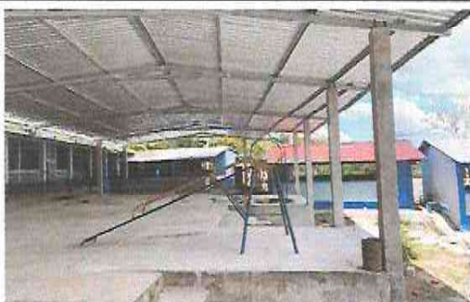
Foto 11: Suministro de lámina troquelada calibre 26 en modulo de patio
