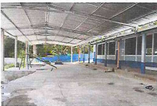
Foto 9: Sustitución de piso de torta de concreto por piso de igual consistencia en el área de recreación
