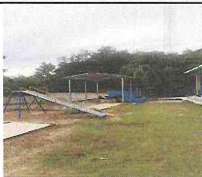
Foto 1: Suministro de lámina troquelada calibre 26 en modulo de patio
