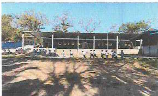
Foto 7: Suministro de estructura de soporte de metal e instalación de lámina troquelada en el modulo de patio
