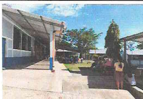
Foto 12: Suministro e instalación de canal de metal con bajante de agua pluvial plástico
