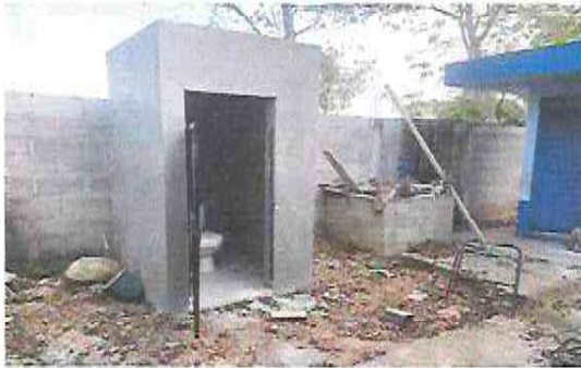
Foto 13: Sustitución de inodoro
