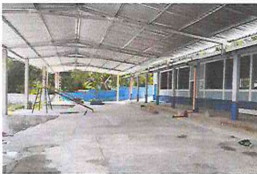
Foto 15: Suministro de estructura de soporte de metal en el modulo del patio
