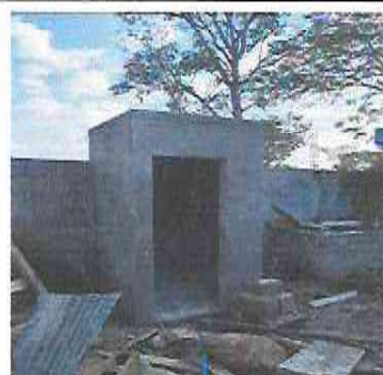
Foto 6: Sustitución de inodoro
