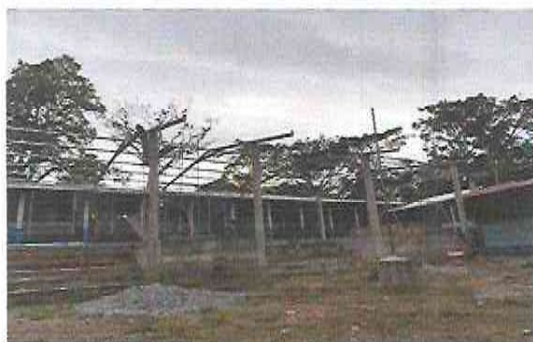
Foto 1: Suministro de estructura de soporte de metal en el modulo del patio
