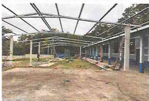
Foto 5: Suministro de estructura de soporte de metal en el modulo del patio
