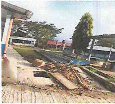
Foto 13: Sustrucción de piso de torta de concreto por piso de igual consistencia en el área de recreación
