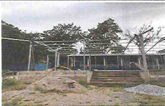
Foto 7: Suministro de estructura de soporte de metal en el modulo del patio
