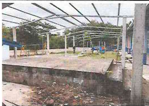
Foto 4: Suministro de estructura de soporte de metal en el modulo del patio
