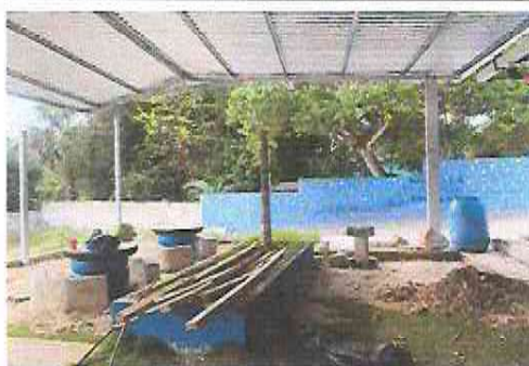
Foto 11: Suministro de lámina troquelada calibre 26 en modulo de patio
