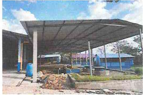
Foto 14: Suministro de lámina troquelada calibre 26 en modulo de patio
