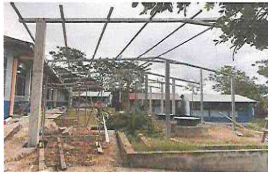
Foto 2: Suministro de estructura de soporte de metal en el modulo del patio
