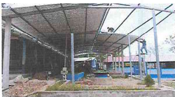
Foto 9: Suministro de lámina troquelada calibre 26 en modulo de patio
