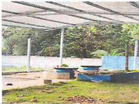
Foto 15: Suministro de lámina troquelada calibre 26 en modulo de patio
