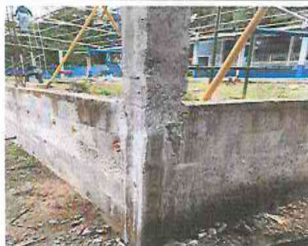
Foto 3: Suministro de estructura de soporte de metal en el modulo del patio
