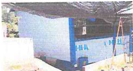
Foto7: Pintura en muros interiores y exteriores
