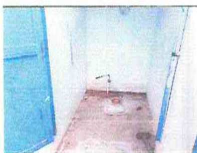
Foto 10: Sustitución de sanitario con sus accesorios
