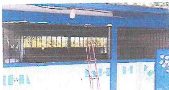
Foto1: Pintura en muros interiores y exteriores
