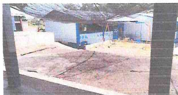
Foto 5: Sustitución de piso de torta de concreto por piso de igual consistencia en el área de recreación
