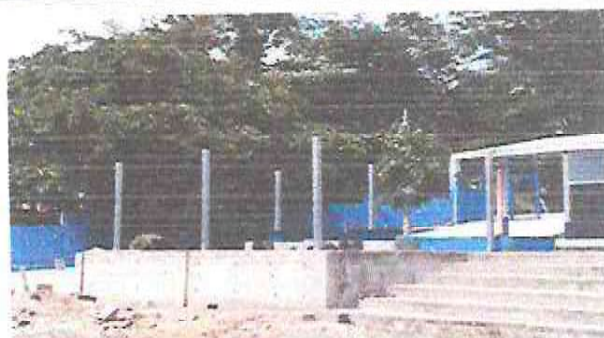
Foto2: Suministro de estructura de soporte de metal y lámina troquelada calibre 26 de escenario
