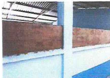
Foto 8: Instalación de Block en ventanas
