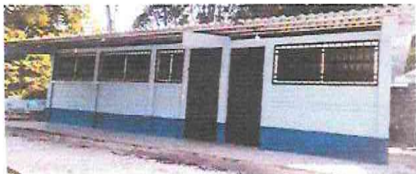
Foto1: Pintura en muros interiores y exteriores de aula, bodega, instalación de luz eléctrica.
