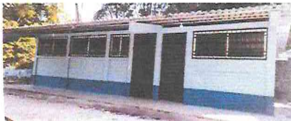
Foto 2: Instalación de ventanas PVC
