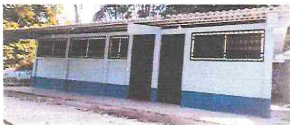
Foto 3: Instalación de balcones de metal y Pintura de puertas de bodega y aula.
