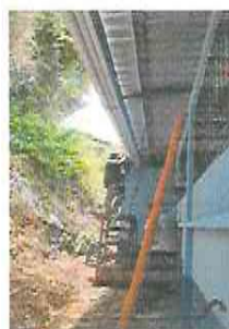
Foto 5. Sustitución de canales de agua.
