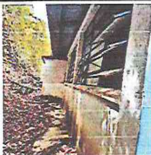
SUSTITUCIÓN DE REPELLO Y CERNIDO EN PAREDES
