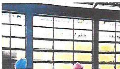
SUSTITUCIÓN DE ESTRUCTURA DE METAL DE VENTANAS
