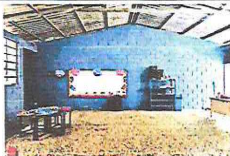
MANTENIMIENTO A INTERIOR Y EXTERIOR DE PINTURA DE LAS AULAS
