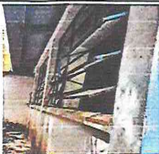
SUSTITUCIÓN DE ESTRUCTURA DE METAL DE LAS VENTANAS (YA ESTAN DETERIORADAS)
