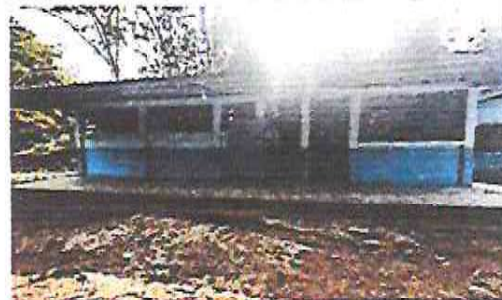
CAMINAMIENTO DE PISO DE TORTA DE CONCRETO Y/O BANQUETA
