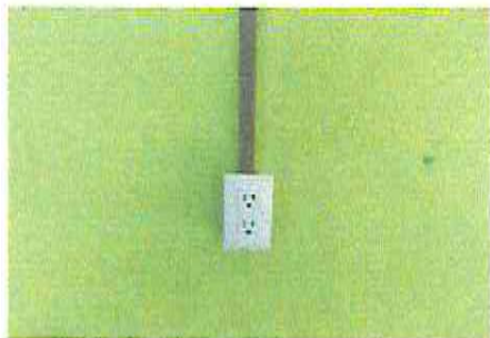
Foto 13: Sustrucción de tomacorrientes dobles
