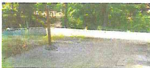
Foto 15: Limpieza de fosa séptica
