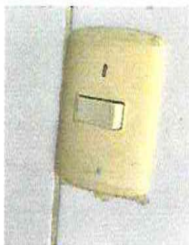
Foto 13: Sustrucción de interruptores simples
