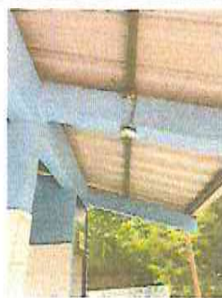
Foto 12: Sustrucción de Plafoneras
