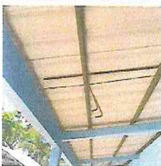
Foto 17: Reparación de cableado eléctrico
