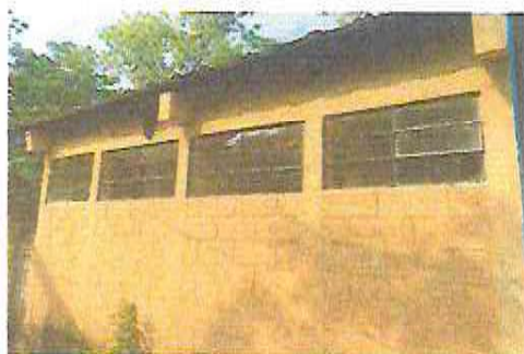
Foto 3: sustitución de ventanas metálicas por ventanas PVC corredizas más mosquitero
