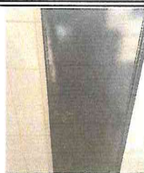
Foto 2: Sustrucción de puerta en servicios sanitarios (0.60x1.80m)
