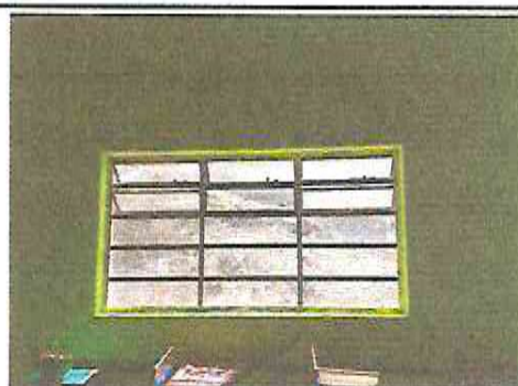
Foto 6: Sustrucción de ventanas metálicas por ventanas PVC corrediza más mosquitero
