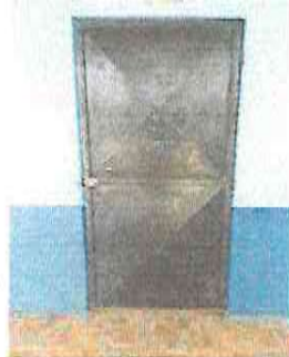
Foto 5: Sustrucción de puerta (1.00x2.00M reforzada con doble lámina)
