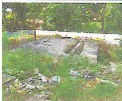
Foto 4: Limpieza de fosa séptica
