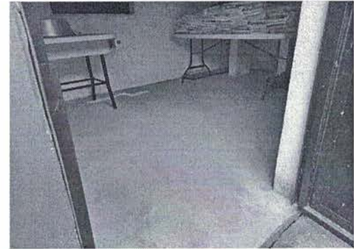
Foto 4: piso existente en donde se colocara piso cerámico y en muros azulejos.
