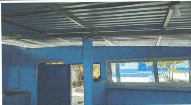
Foto 3: INSTALACION DE BALCONES CON SEDAZO EN COSINA.
