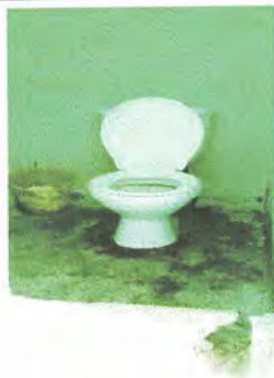
Foto 9. SUSTITUCIÓN DE INODORO
