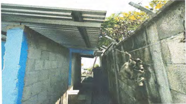
Foto1: INSTALACION DE CANAL Y BAJADAS DE AGUA.
