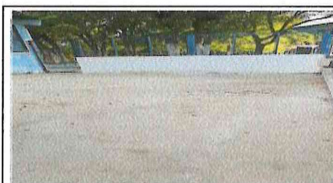
Foto 6: finalización de plancha de concreto y puerta
