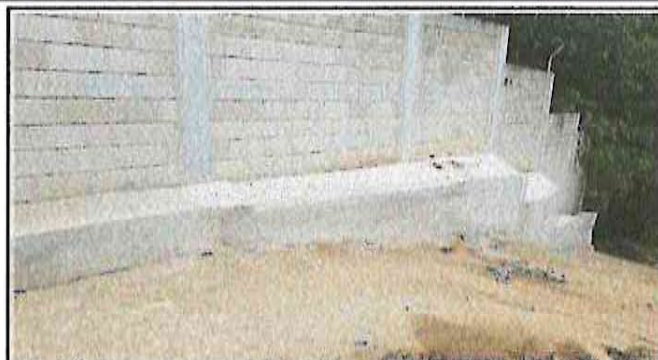
Foto 2: finalización de muro de contención
