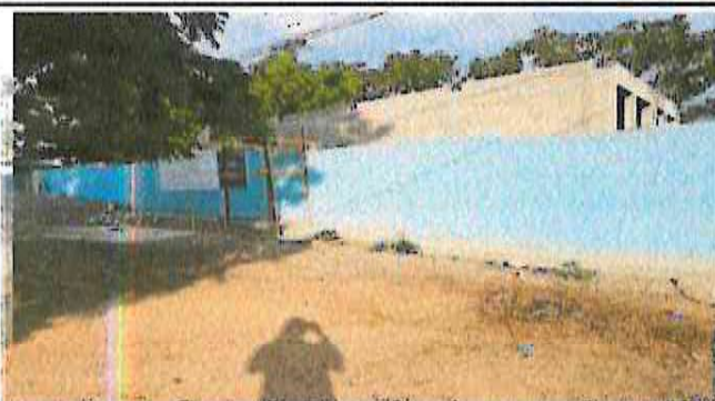
Foto 3: finalización de banqueta
