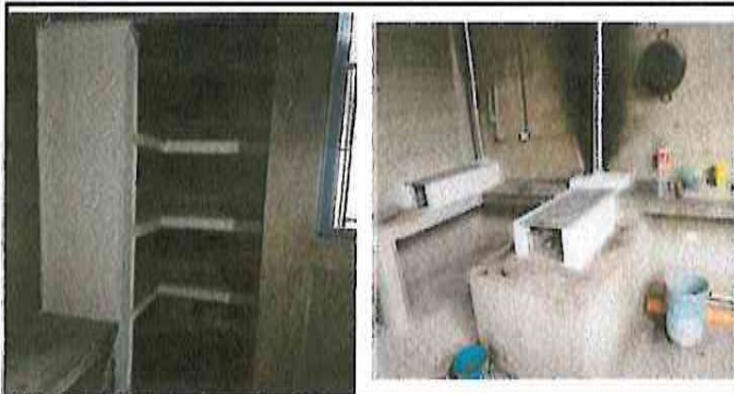
Foto 4: finalización de tres muebles de concreto
