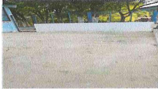
Foto 2: finalización de muro en area de parvulos, instalación de maya, fabricación e instalación de puerta y cambio de torta de cemento
