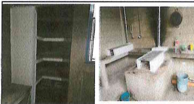
Foto 4: finalización de tres muebles de concreto
