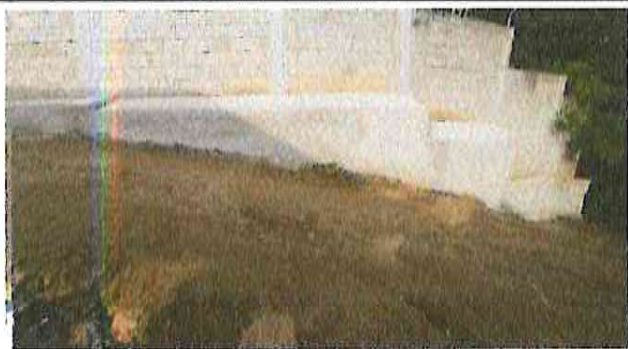
Foto 3: finalización de muro de contención (erosión de muro perimetral)
