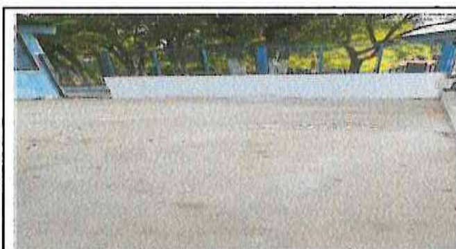
Foto 6: finalización de plancha de concreto y puerta
