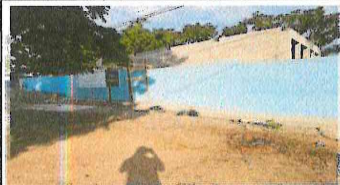
Foto 1: Finalización de Banqueta 28 mts
