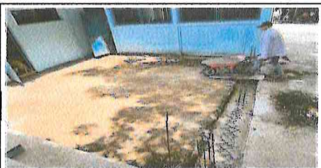
Foto 6: sustitución de plancha de concreto y puerta
