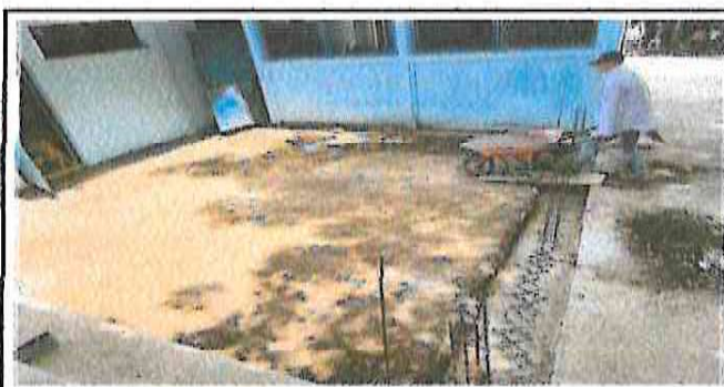
Foto 6: sustitución de plancha de concreto y puerta
