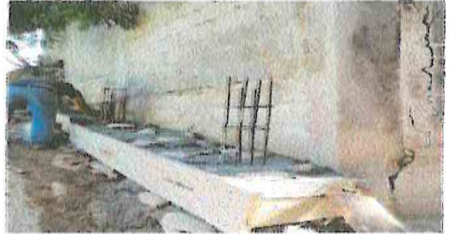
Foto 2: muro de contención
