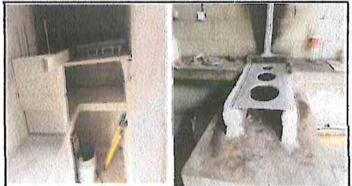
Foto 4: fabricación de tres muebles de concreto
