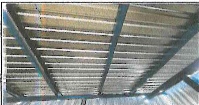
Foto 5: sustitución de lamina de metal por troquelada y metal por madera
