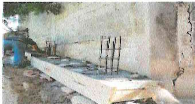
Foto 2: muro de contención
