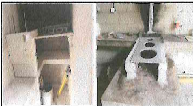
Foto 4: fabricación de tres muebles de concreto
