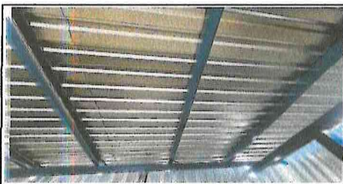
Foto 5: sustitución de lamina de metal por troquelada y metal por madera
