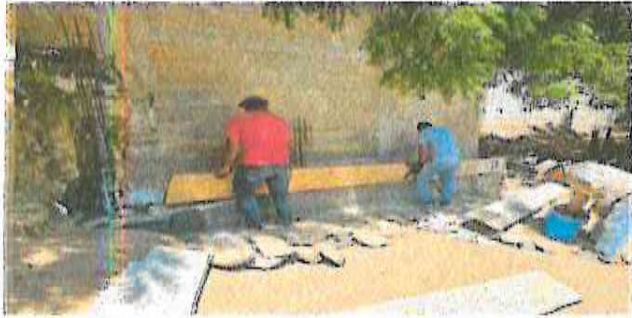
Foto 1: muro de contension
