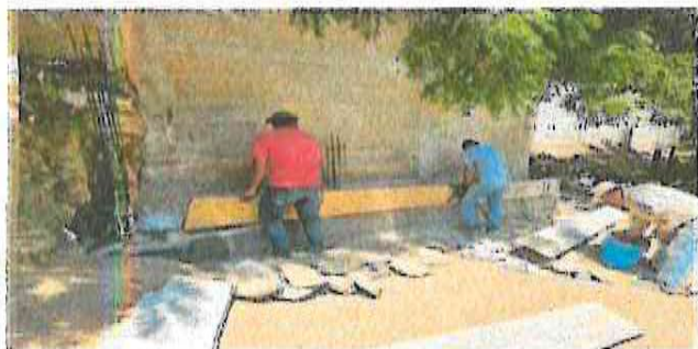
Foto1: muro de contension
