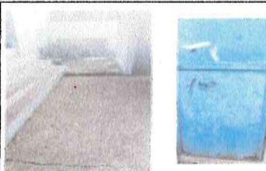
FOTO 6: SUSTITUCION DE PLANCHAS DE CONCRETO Y PUERTA
