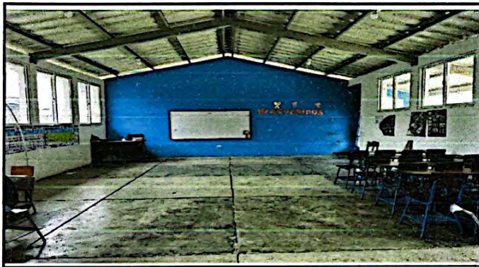
Foto 9: Modulos de aulas que necesitan cambio de piso de cemento por cerámica
