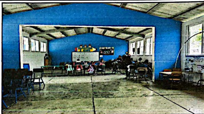
Foto 8: Aulas del modulo I necesitan división
