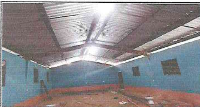
FOTOGRAFIA: SUSTITUCION ESTRUCTURA DE SOPORTE DE METAL, POR METAL EN MODULO DE AULAS
