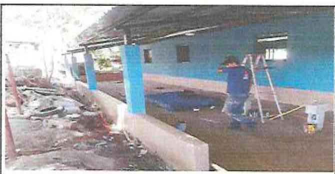
FOTOGRAFIA: SUSTITUCION DE LAMINA, POR LAMINA TROQUELADA CALIBRE 26 EN MODULO DE CORREDOR
