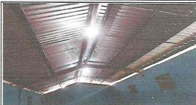
FOTOGRAFIA: SUSTITUCION DE SOPORTE DE METAL, POR METAL Y REPARACION DE SISTEMA ELECTRICO + ACCESORIOS EN MODULO DE AULA
