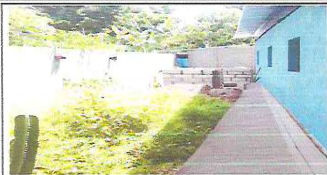
FOTOGRAFIA: BANQUETA DE CONCRETO
