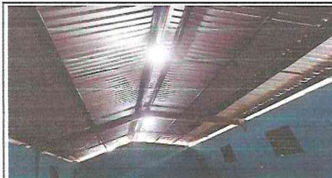
FOTOGRAFIA: SUSTITUCION DE LAMINA, POR LAMINA TROQUELADA CALIBRE 26, SUSTITUCION ESTRUCTURA DE SOPORTE DE METAL, POR METAL EN MODULO DE AULA
