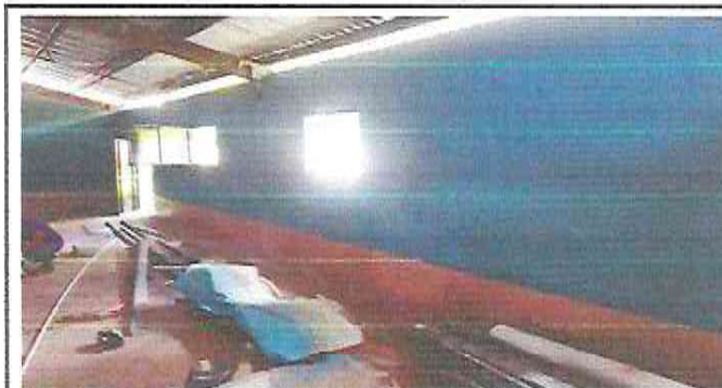
FOTOGRAFIA: PINTURA EN MUROS INTERIOR Y EXTERIOR, SUSTITUCION DE LAMINA, POR LAMINA TROQUELADA CALIBRE 26 EN MODULO DE AULA
