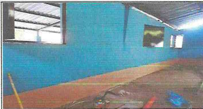
FOTOGRAFIA: PINTURA EN MUROS INTERIOR Y EXTERIOR
