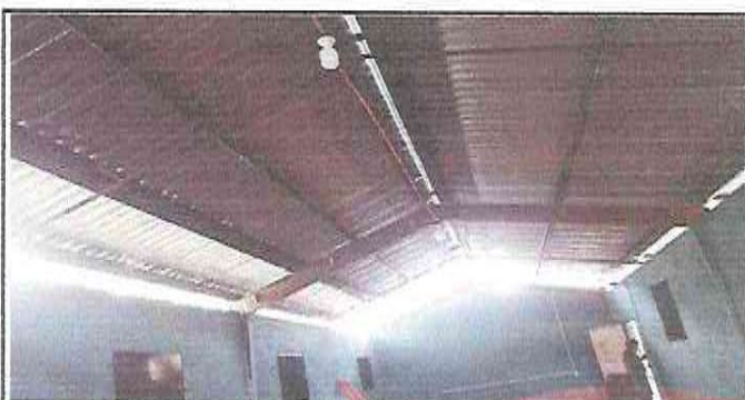
FOTOGRAFIA: SUSTITUCION DE SOPORTE DE METAL, POR METAL, REPARACION DE SISTEMA ELECTRICO + ACCESORIOS, SUSTITUCION DE LAMINA, POR LAMINA TROQUELADA CALIBRE 26 EN MODULO DE
