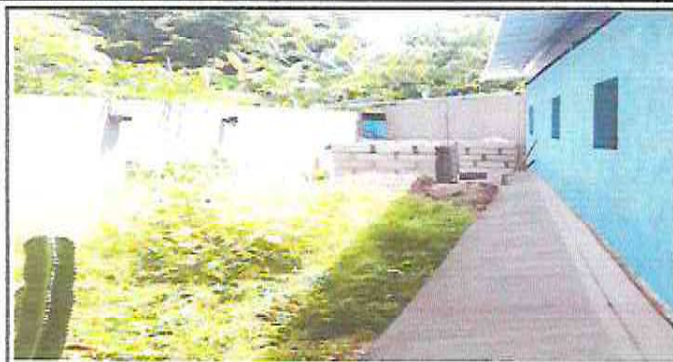
FOTOGRAFIA: BANQUETA DE CONCRETO
