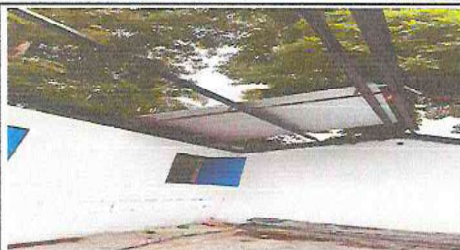
FOTOGRAFIA: SUSTITUCION DE LAMINA, POR LAMINA TROQUELADA CALIBRE 26 EN MODULO DE AULA
