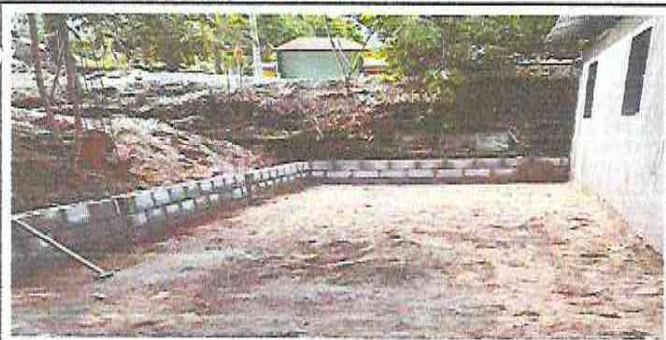
FOTOGRAFIA: PISO DE TORTA DE CONCRETO, MURO DE CONTENCION EN MODULO DE CORREDOR
