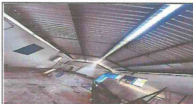
FOTOGRAFIA: SUSTITUCION DE LAMINA, POR LAMINA TROQUELADA CALIBRE 26, SUSTITUCION ESTRUCTURA DE SOPORTE DE METAL, POR METAL EN MODULO DE AULA
