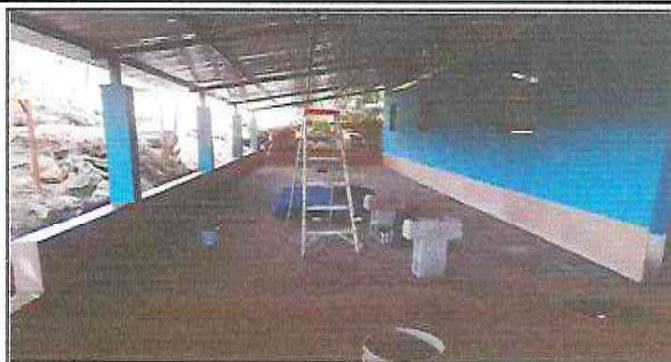
FOTOGRAFIA: PINTURA EN MUROS INTERIOR Y EXTERIOR
