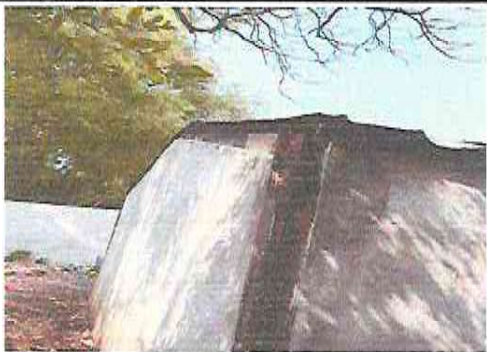
FOTOGRAFIA: SUSTITUCION ESTRUCTURA DE SOPORTE DE METAL, POR METAL EN MODULO DE AULAS
