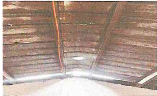
FOTOGRAFIA: SUSTITUCION DE SOPORTE DE METAL, POR METAL Y REPARACION DE SISTEMA ELECTRICO + ACCESORIOS EN MODULO DE AULA
