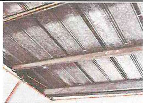
FOTOGRAFIA: SUSTITUCION DE SOPORTE DE METAL, POR METAL, REPARACION DE SISTEMA ELECTRICO + ACCESORIOS, SUSTITUCION DE LAMINA, POR LAMINA TROQUELADA CALIBRE 26 EN MODULO DE
