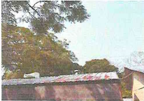
FOTOGRAFIA: SUSTITUCION DE LAMINA, POR LAMINA TROQUELADA CALIBRE 26 EN MODULO DE AULA
