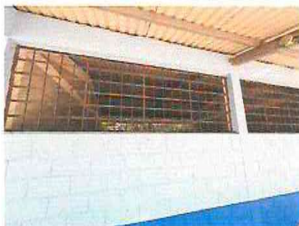
Foto 15: PINTURA DE AULAS
