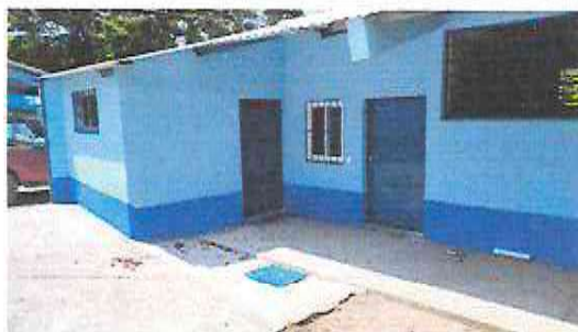
Foto 5: Sustrucción de puerta de metal de la cocina
