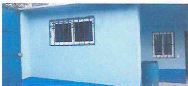
Foto 3: Sustrucción de estructuras de metal de ventanas (varias ventanas)
