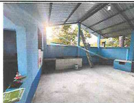
Foto 2: Sustrucción de estructura de soporte de madera por metal (Costanera)
