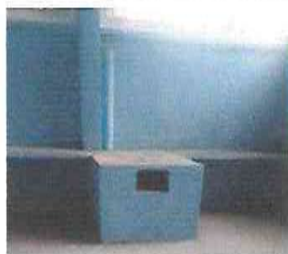
Foto 9: Sustrucción de estufa rural completa (Incluye polletón, plancha de metal y chimenea)
