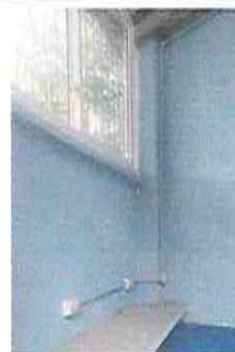
Foto 10: SUSTITUCIÓN DE DUCTO ELECTRICO CON SUS ACCESORIOS
