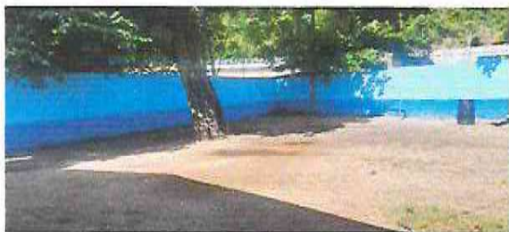
Foto 13: APLICACIÓN PINTURA MURO PERIMETRAL
