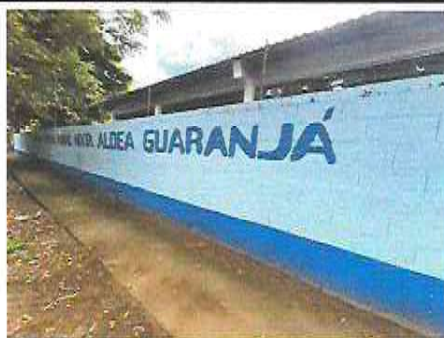
Foto 14: PINTURA MURO EXTERIOR
