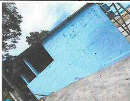
Foto 4: Sustrucción de estructura de lámina por lámina troquelada aluzinc cal. 26
