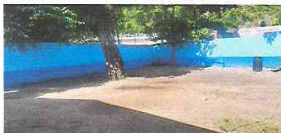
Foto 7: Sustrucción de muro perimetral de block
