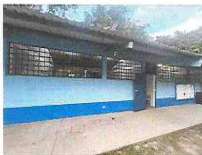
Foto 16: QUITAR VIDRIOS EN MAL ESTADO
