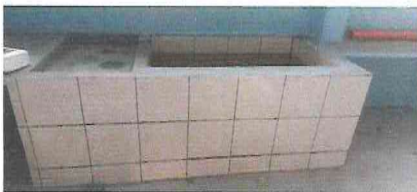
Foto1: Sustrucción de lavatrastos por pila de concreto formal
