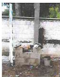
Foto 9: Sustrucción de estufa rural completa (Incluye polletón, plancha de metal y chimenea)
