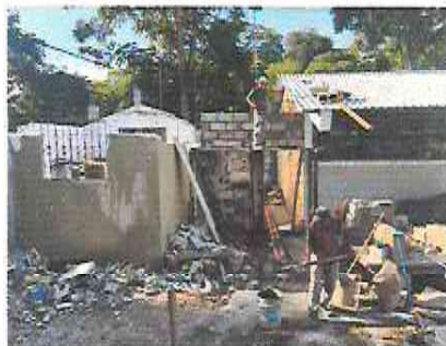
Foto 11: SUSTITUCIÓN DE DUCTO ELECTRICO CON SUS ACCESORIOS
