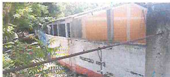
Foto 14: PINTURA MURO EXTERIOR
