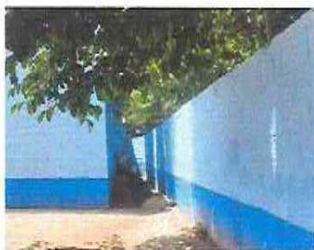
Foto13: APLICACIÓN PINTURA MURO PERIMETRAL
