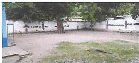
Foto 7: Sustrucción de muro perimetral de block
