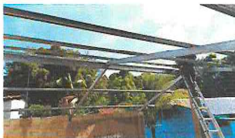
Foto 2: Sustrucción de estructura de soporte de madera por metal (Costanera)
