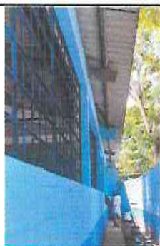
Foto 15: PINTURA DE AULAS
