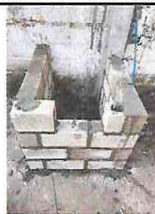
Foto 8: Sustrucción de estufa rural completa (Incluye polletón, plancha de metal y chimenea)
