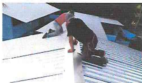
Foto 4: Sustrucción de estructura de lámina por lámina troquelada aluzinc cal. 26
