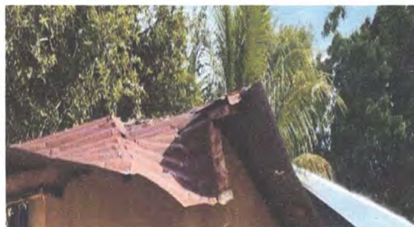
Foto 4: Sustrucción de estructura de lámina por lámina troquelada aluzinc cal. 26
