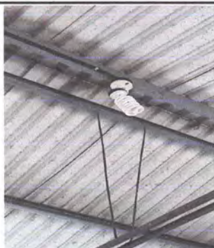
SUSTITUCIÓN DE DUCTO ELECTRICO CON SUS ACCESORIOS
