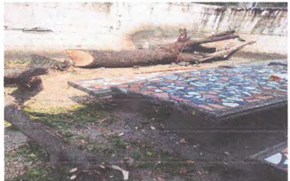
REPARACIÓN DE MURO PERIMETRAL
