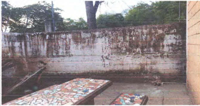
REPARACIÓN DE MURO PERIMETRAL
