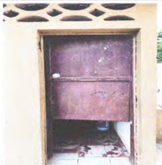
Foto 5: Sustrucción de puerta de metal de la cocina
