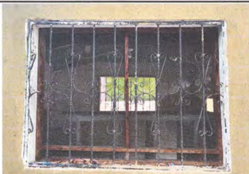
Foto 3: Sustrucción de estructuras de metal de ventanas (varias ventanas)
