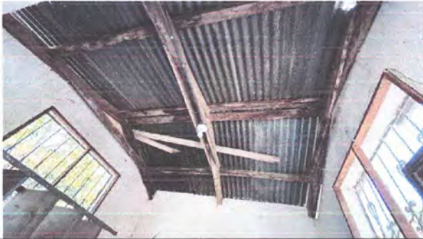
CUBIERTA DE LAMINA
