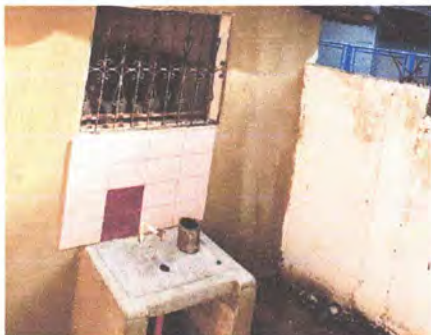
Foto1: Sustrucción de lavatrstos por pla de concreto formal
