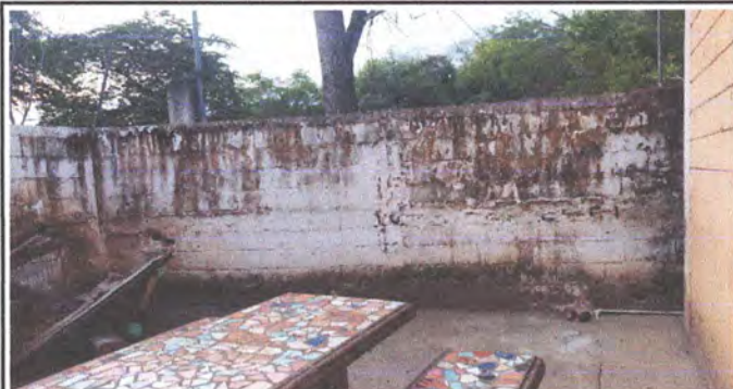
REPARACIÓN DE MURO PERIMETRAL
