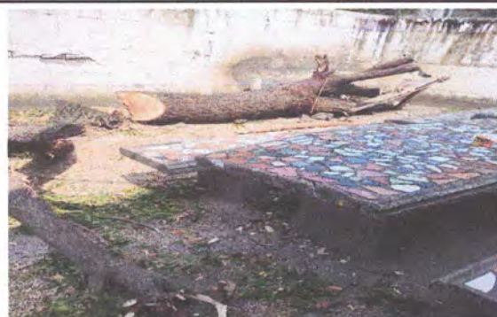
REPARACIÓN DE MURO PERIMETRAL
