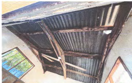
Foto 2: Sustrucción de estructura de soporte de madera por metal (Costanera)
