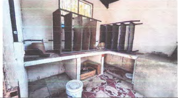
REPARACION DE COCINA
