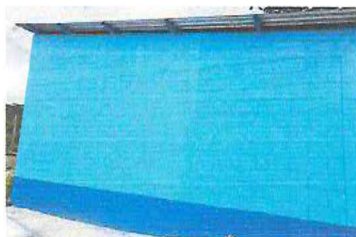
Foto 4: Pintura en muros interiores y exteriores
