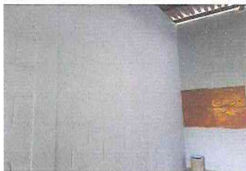
Foto 2: Suministro de pinturas en puertas, ventanas y balcones
