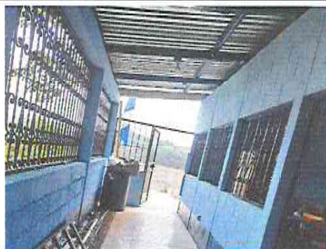
Foto 7: Suministro de pinturas en puertas, ventanas y balcones
