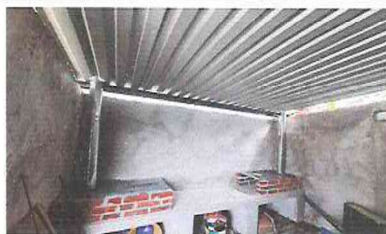
Foto 6: Sustitución de estufa rural completa
