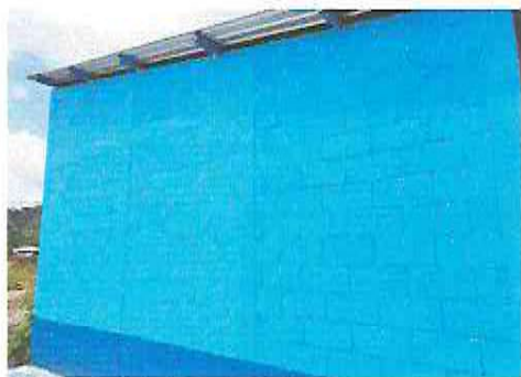
Foto 9: Pintura en muros interiores y exteriores
