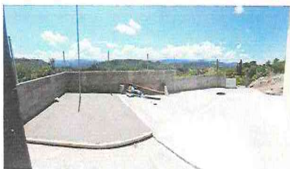
Foto 3: Reparación de pañuelos y caminamiento entrada principal
