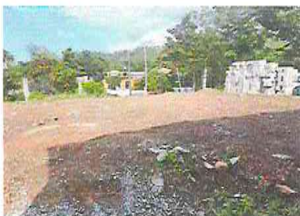
Foto 7: Suministro e instalación de arriates y muro de contención
