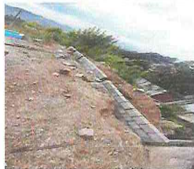
Foto 8: Suministro e instalación de arriates y muro de contención
