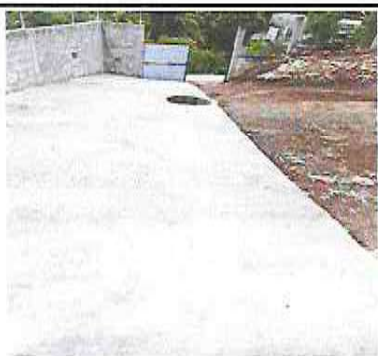
Foto 3: Reparación de pañuelos y caminamiento entrada principal
