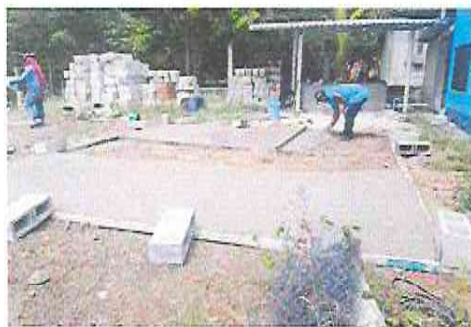
Foto 13: Suministro e instalación de galera en la pila
