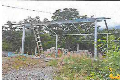
Foto 12: Suministro e instalación de galera en la pila
