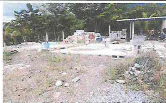
Foto 10: Suministro e instalación de galera en la pila
