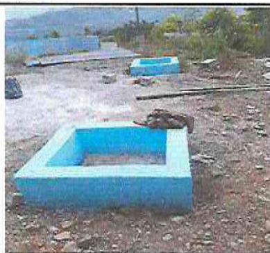
Foto 9: Suministro e instalación de arriates y muro de contención
