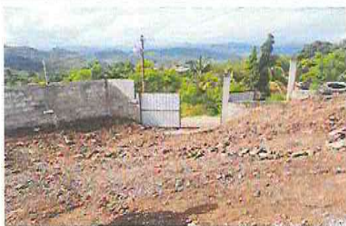
Foto 1: Reparación del muro perimetral
