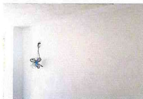
Foto 4: Sustitución de ducto eléctrico más accesorios
