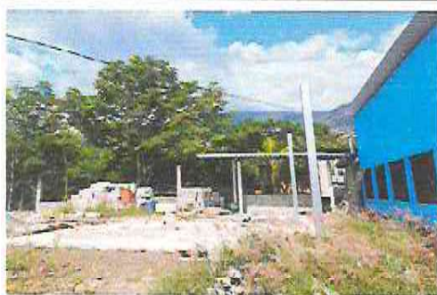
Foto 11: Suministro e instalación de galera en la pila
