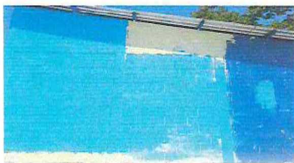
Foto 5: Pintura en muros interiores y exteriores
