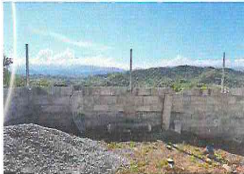
Foto 2: Reparación del muro perimetral
