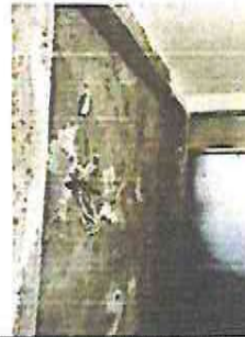
REPARACION DE REPELLO Y CERNIDO DE PAREDES (CUANDO APLIQUE)
