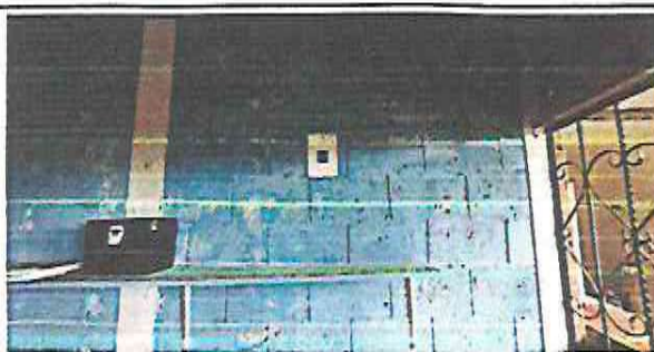
PINTURA EN MUROS INTERIORES Y EXTERIORES
