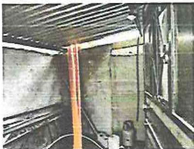
REPARACION DE COCINA
