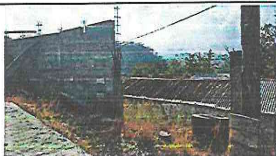
REPARACIÓN DE MURO PERIMETRAL ✓
