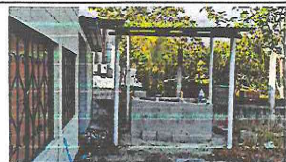
PINTURA EN MUROS INTERIORES Y EXTERIORES
