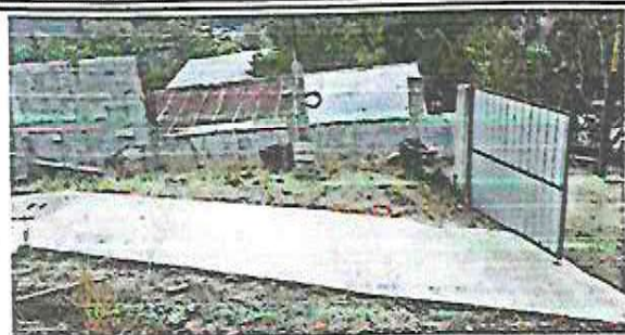
REPARACIÓN DE MURO PERIMETRAL ✓
