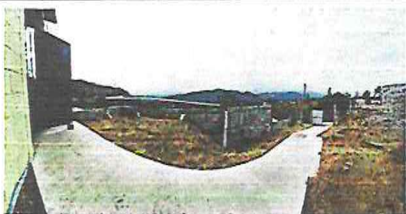
REPARACIÓN DE PAÑUELOS
