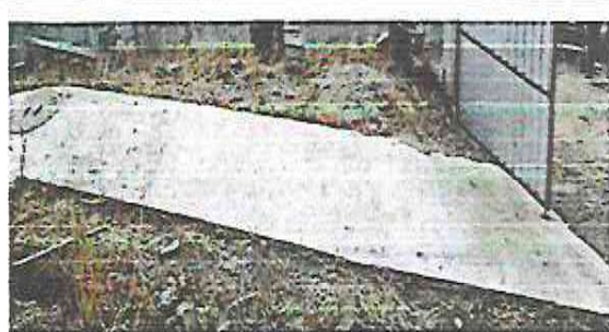
REPARACIÓN DE PAÑUELOS
