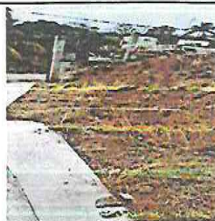
IMPERMEABILIZACIÓN DE LOSA DE PATIO.
