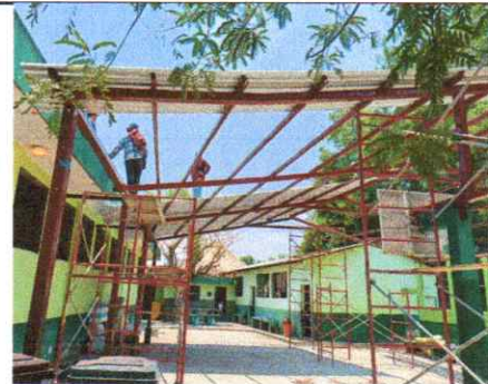
Foto 10: Lijado y pintado con pintura anticorrosiva de costaneras
