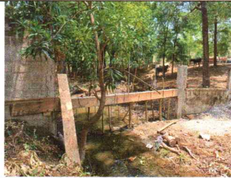
Foto 8: Continuación y mejoramiento de muro perimetral
