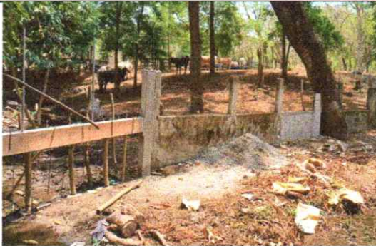
Foto 9: Instalación de malla en muro perimetral
