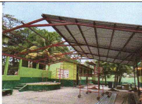
Foto 6: Instalación de lámina en área de deportes
