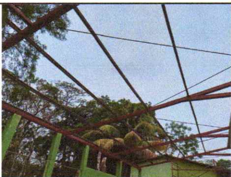
Foto 3: Remoción de lámina antigua
