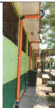
Foto 4: Instalación de bajadas de agua
