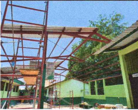
Foto 7: Colocación de lámina nueva en área de deportes
