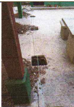
Foto 5: Abertura de agujeros para muro de división entre área de deportes y área de clases
