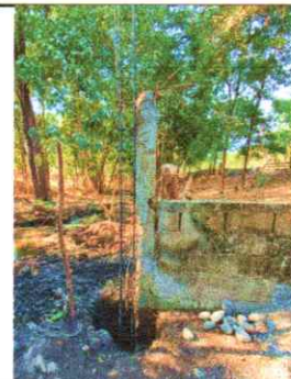
Foto 12: Armado para realización de columnas en muro perimetral
