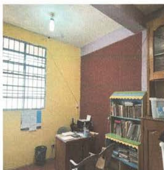
Foto 9: pintura en interior y exterior de Dirección
