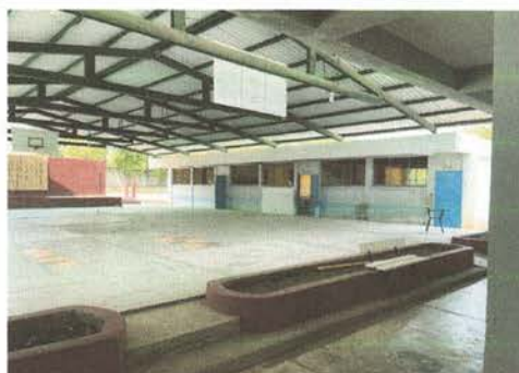
Foto 6: sustitución de lámparas LED
