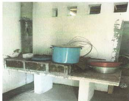
Foto 3: sustitución de estufa de leña por mesa de concreto y tallado de puerta
