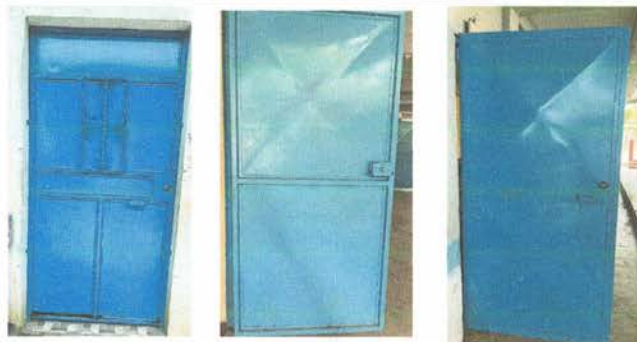
Foto 5: mantenimiento a puertas de metal
