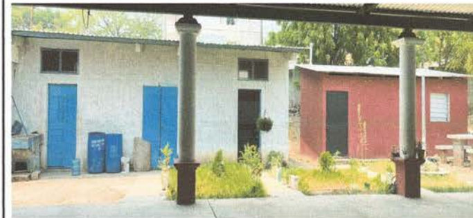
Foto 10: pintura en baños y cocina
