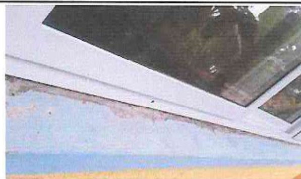
Foto 14: Sustitución de estructura de ventana por ventana de PCV color blanco y cedazo 1.25 y 3.47 mts cuadrados
