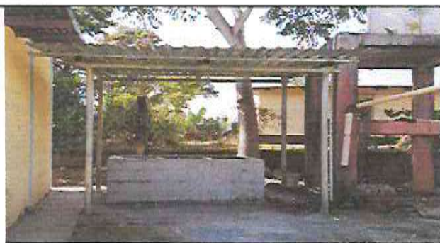
Foto 9: Sustrucción de pila de concreto de un lavador por pila de concreto de dos lavadores 1x2mts.
