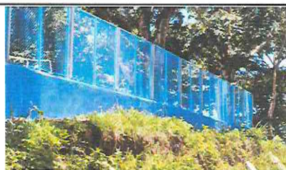
Foto 12: Sustrucción de pila de concreto de un lavador por pila de concreto de dos Foto
