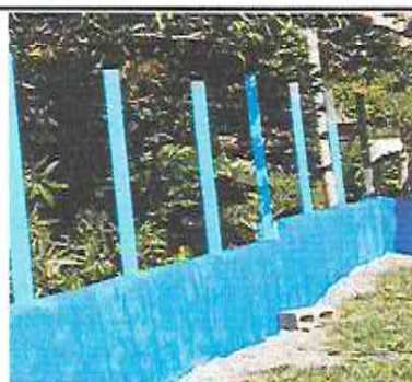
Foto11: Sustrucción de pila de concreto de un lavador por pila de concreto de dos
