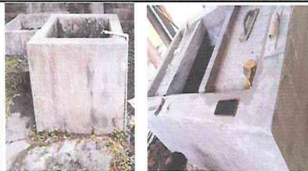
Foto 8: Sustrucción de pila de concreto de un lavador por pila de concreto de dos lavadores 1x2mts.
