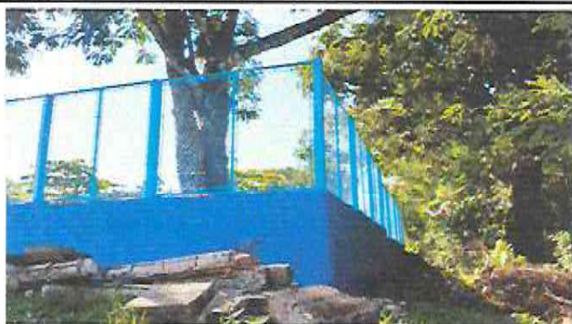
Foto 13: Sustitución de pila de concreto de un lavador por pila de concreto de dos Foto 10: Pintura de muro perimetral y muros 200 metros lineales
