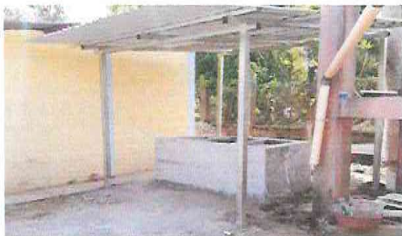
Foto 7: Sustrucción de techo de madera por techo de metal y lámina troquelada aluznic calibre 26 de 3x3.5mts
