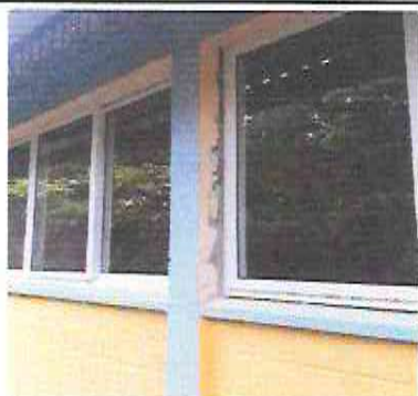
Foto 15: Sustitución de estructura de ventana por ventana de PCV color blanco y cedazo 1.25 y 3.47 mts cuadrados
