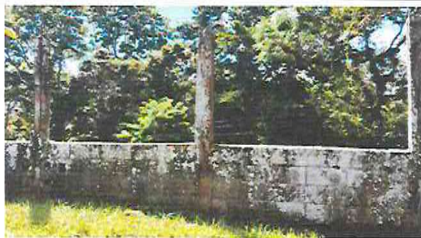
Foto1: Repello de muro perimetral y columnas 200 metros lineales
