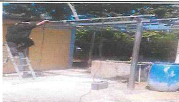
Foto 3: Sustitución de techo de madera por techo de metal y lámina troquelada aluznic calibre 26 de 3x3.5mts
