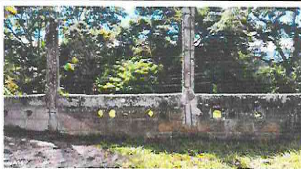
Foto2: Repello de muro perimetral y columnas 200 metros lineales
