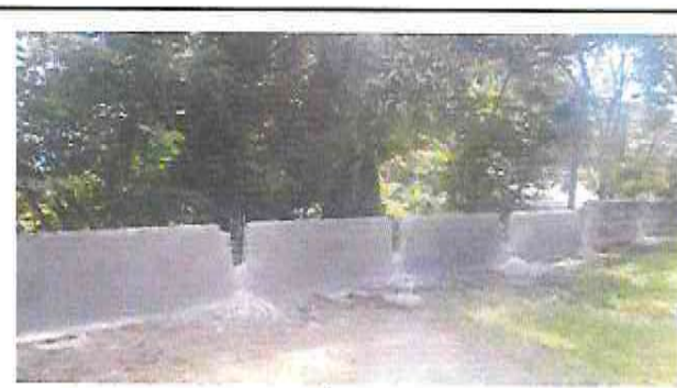
Foto4: Repello de muro perimetral y columnas 200 metros lineales
