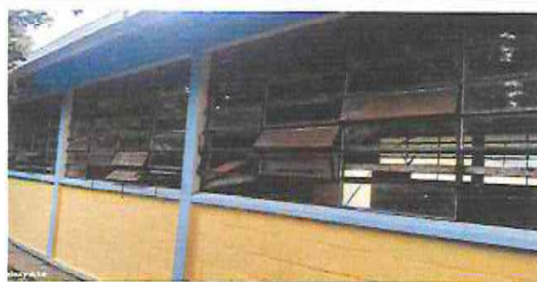
Foto 5: Sistitución de estructura de metal de ventanas por ventanas de PCV y su cedezo de 1.58 y 3.47 mts cuadrados
