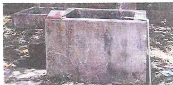
Foto 6: Sustitución de pila de concreto de un lavador por pila de concreto de dos lavadores 1x2 mts.
