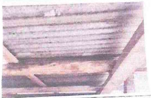
Foto 1: Sustitución de techo de madera por techo de metal y lámina troquelada aluznic calibre 26 de 3x3.5 mts
