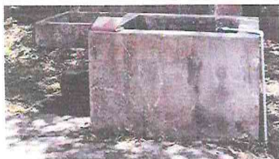
Foto 5: Demolición de pila
