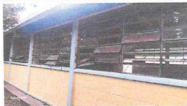
Foto 4: Sustitución de Estructura de metal de ventana por ventana de PVC color blanco y su cedazo de 1.58 y 3.47 mts cuadrados
