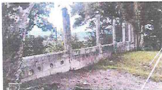
Foto 1: Repello de muro perimetral y columnas 200 metros lineales
