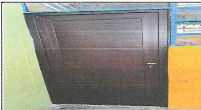
Sustitución de puerta
