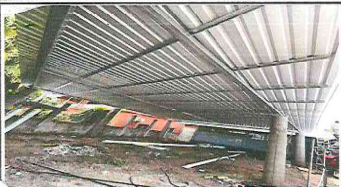
Foto 1: Sustitución de laminas por laminas troqueladas calibre 26 y estructura de soporte de madera por metal
