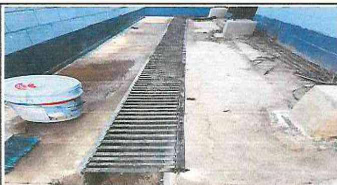
Foto 3: Sustitución de tubería de línea principal
