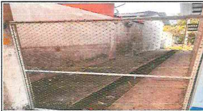
Foto 2: Sustitución de puerta de metal
