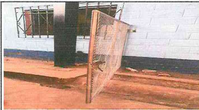
Foto 2: Sustitución de puerta de metal
