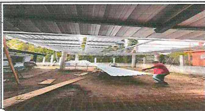
Foto 1: Sustitución de laminas por lamina troquelada calibre 26 y estructurado de soporte de madera por metal
