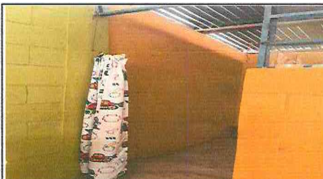
Foto 4: Sustitución de puerta
