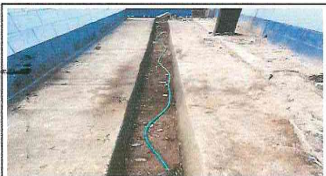
Foto 3: Sustitución de tubería de línea principal
