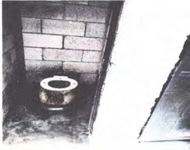
Foto1: Sustrucción de sanitarios con sus accesorios
