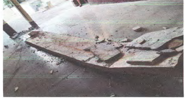
Foto 2: Sustitución de canales de concreto y bajada de agua pluvial
