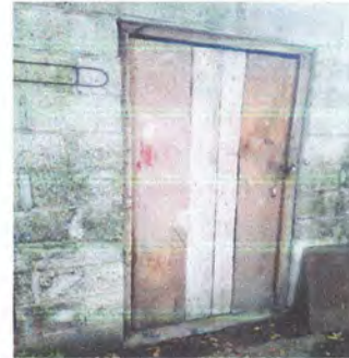
Foto 4: Sustitución de puerta de madera por puerta de metal de 1.20 mts de ancho por 2.15 mts de alto
