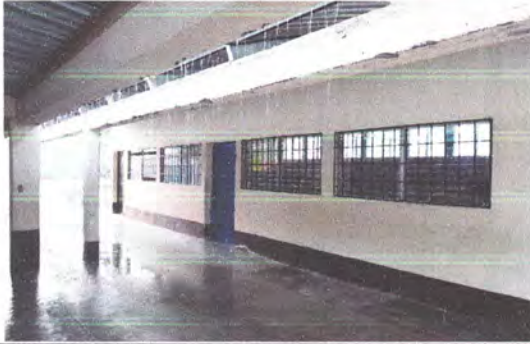
Foto 1: Sustitución de canales de concreto y bajada de agua pluvial
